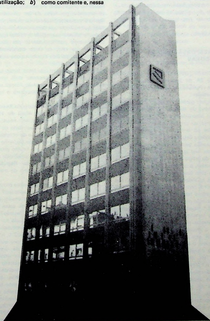
EDIFÍCIO DO INSTITUTO NACIONAL DE SEGUROS
